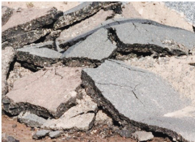
Зураг 10. Авто замын хуучин асфальт бетон (Жишээ зураг)
